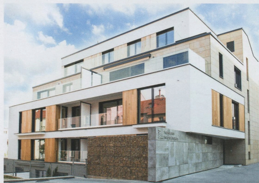
Rezidence Nad Ostrovem, Praha
