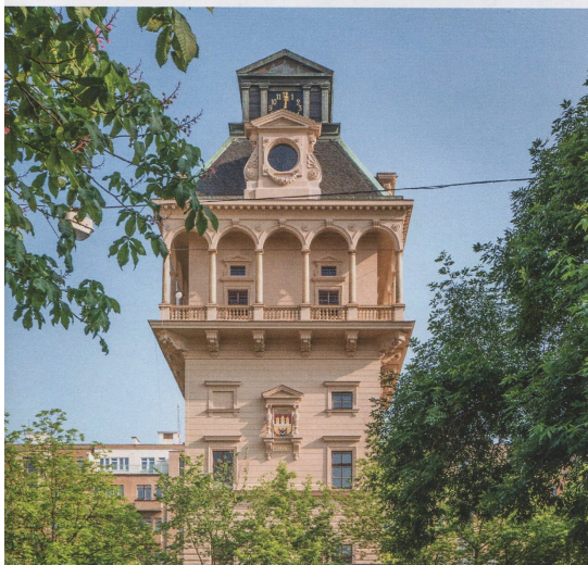
Rekonstrukce Vodárenské věže Na Výšinách, Praha
