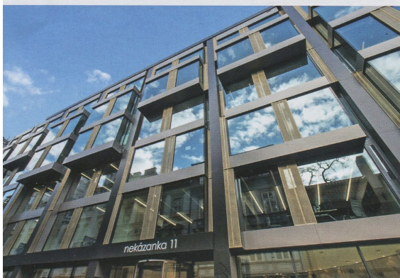
Administrativní budova Nekázanka 11, Praha
