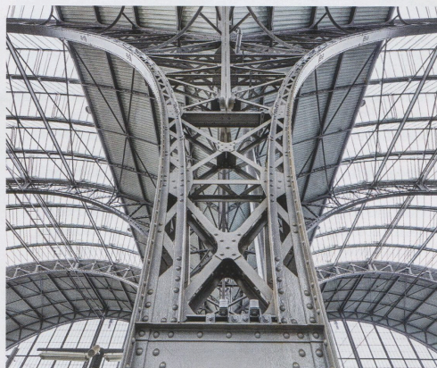
Rekonstrukce zastřešení haly železniční stanice Praha Hlavní nádraží
